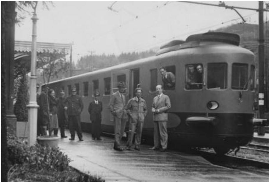
Abb. 5: Dampftriebwagen mit Doble-Antrieb
